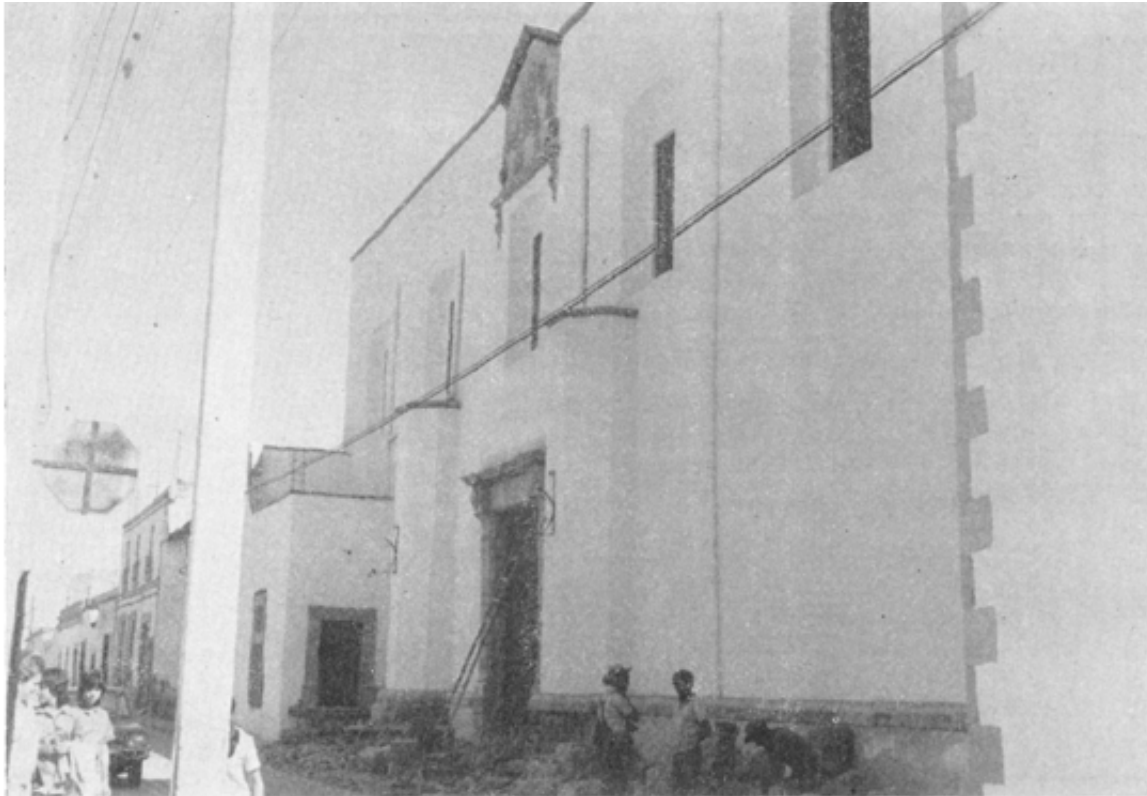
Portada lateral del Beaterio de Carmelitas, durante las obras de reparación.
